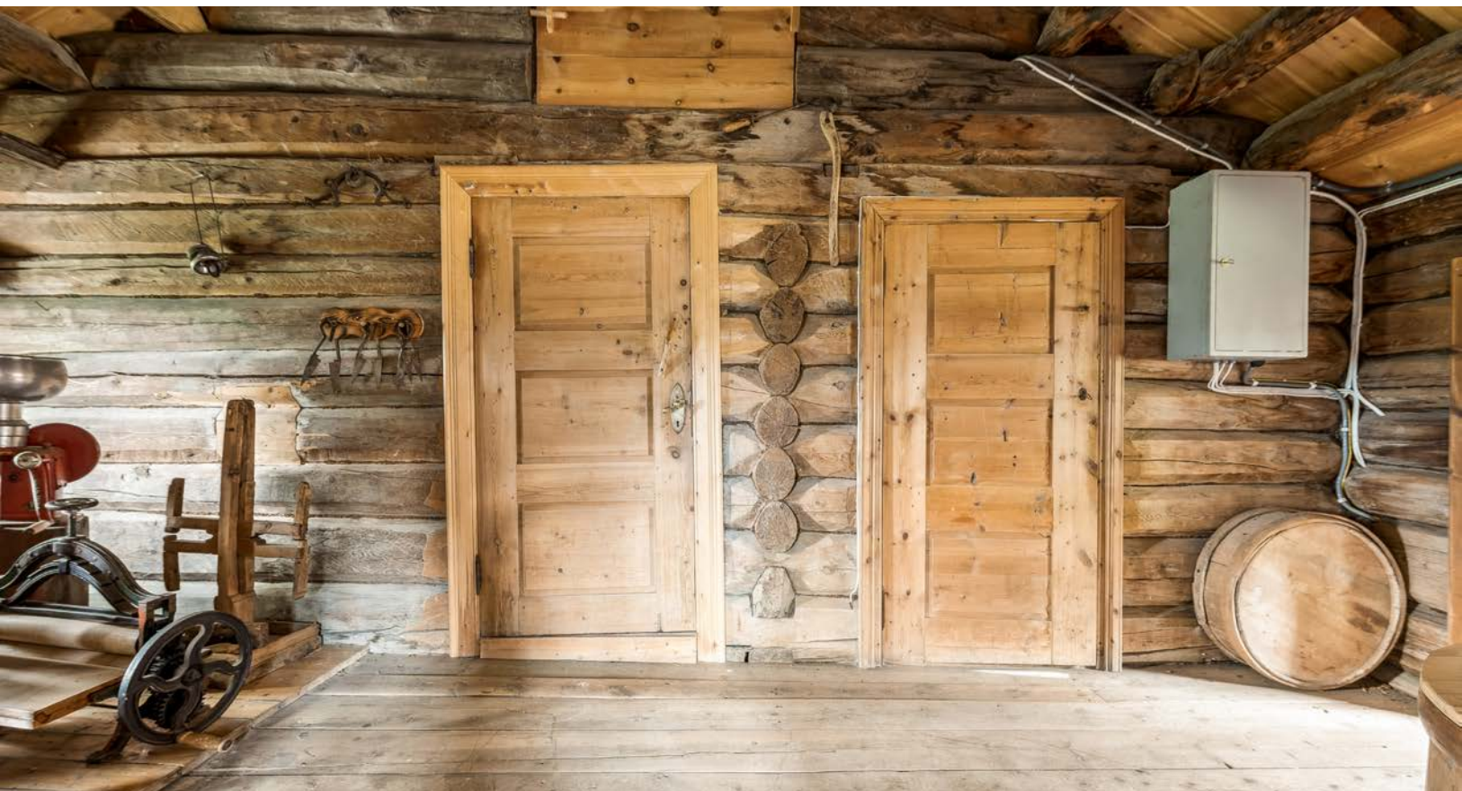
Gang i 2. etasje på eldre bolig.
