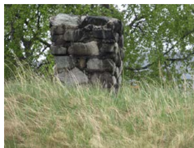
Pipe over tak tilbygg
