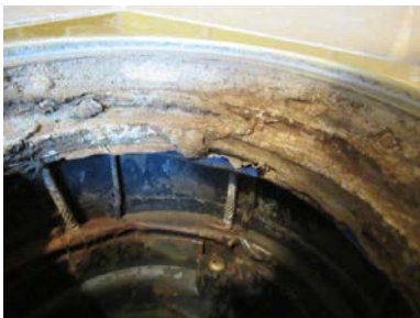
Synlig del av mansjett i sluk.
