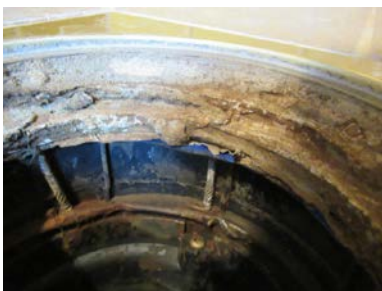
Synlig del av mansjett i sluk.
