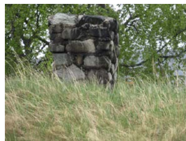
Pipe over tak tilbygg
