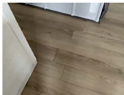
Gliper i flere laminatskjøter.
