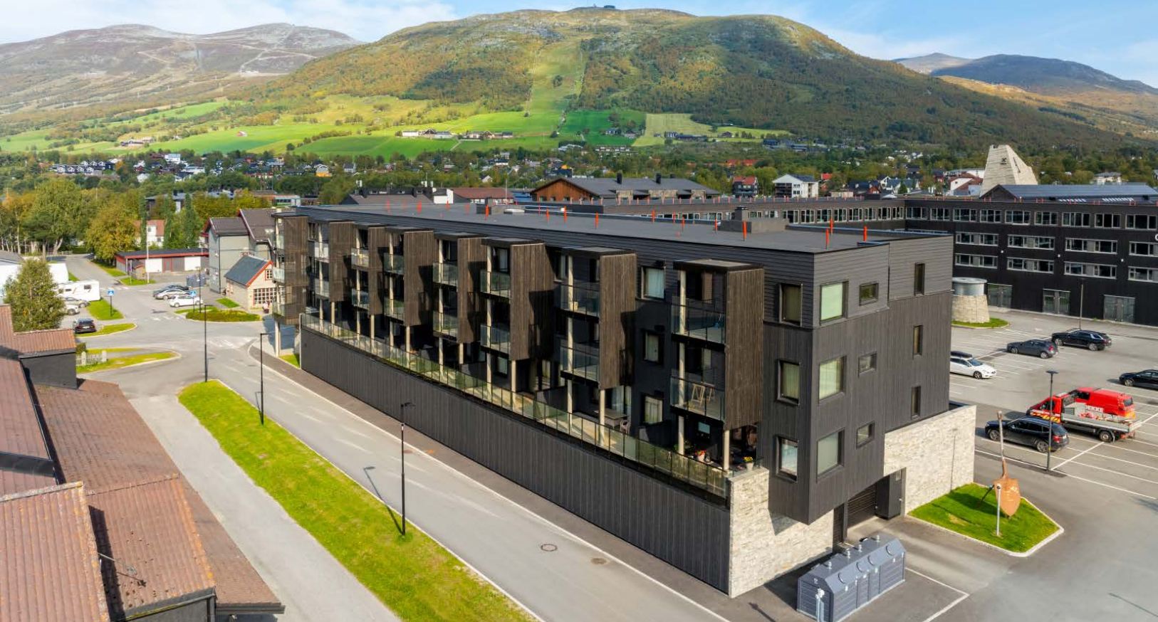
Bygget har garasje på bakkeplan og heis
