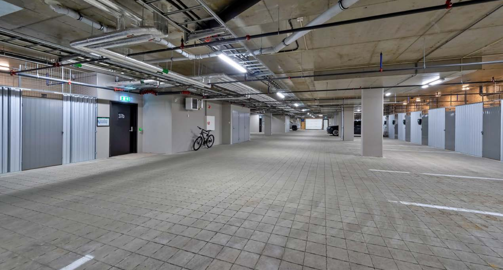
Garasjeanlegg med boder og inngang til trapp/heis til de to leilighetsfløyene
