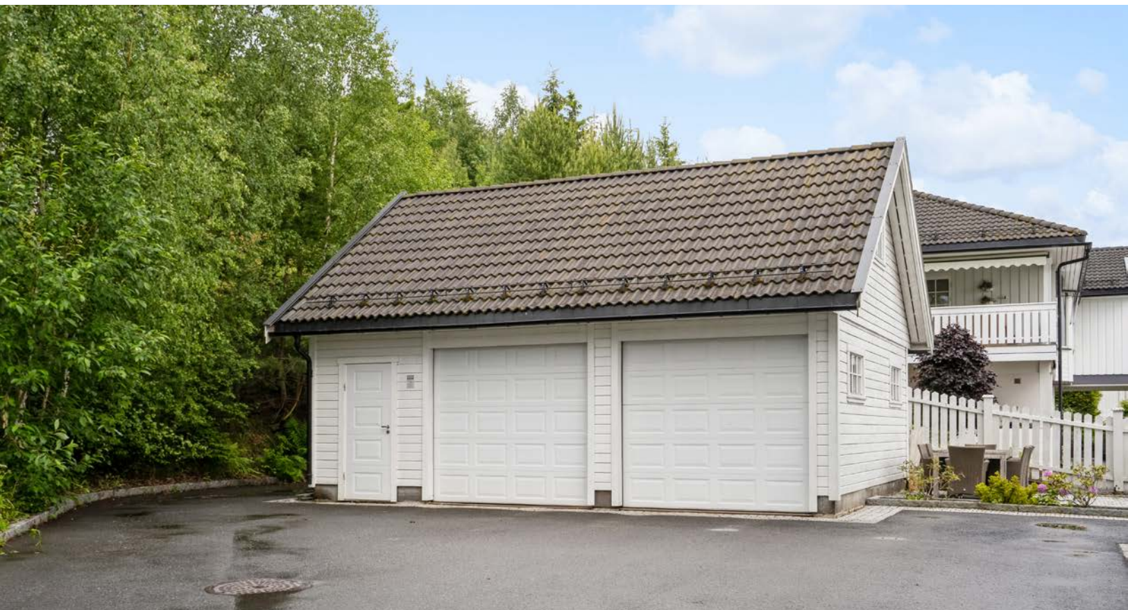
Dobbel garasje med hems. Det er installert elbil lader.
