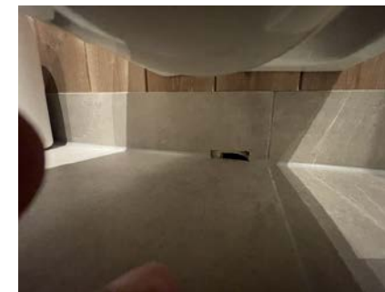
Hull for synliggjøring av lekkasjevann fra innebygget systerne.
