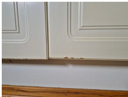
Fuktsveller på front.
