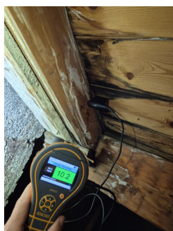
Ikke målt noe unormalt med fukt.
