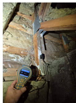
Ikke målt noe unormalt med fukt.
