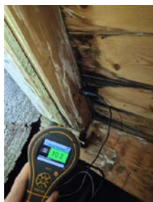
Ikke målt noe unormalt med fukt.
