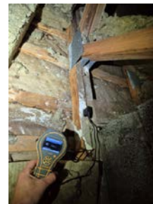
Ikke målt noe unormalt med fukt.
