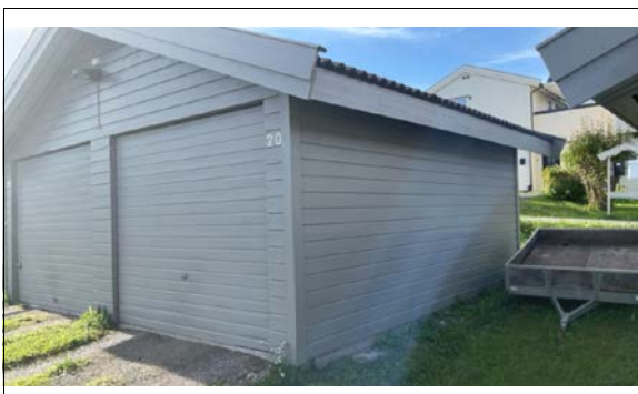
Garasjeplass i fellesanlegg
