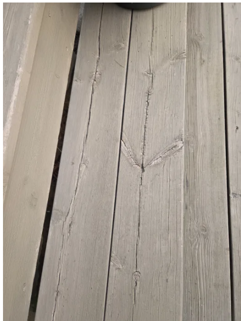
Bilde av bordene i trappa.
