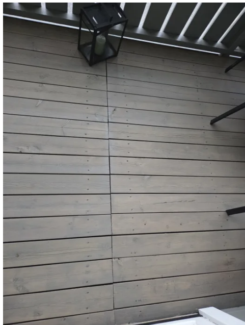
Bildet viser hvor terrasbordene er skjøtet.
