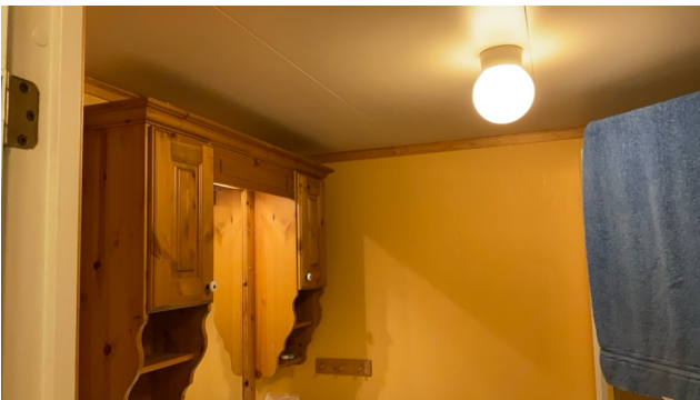
Malt strie på vegg, himlingsplater i tak.
