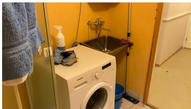
Opplegg for vaskemaskin og utslagsvask.
