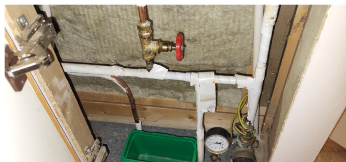
Vannrør i luke i gang underetasje.
