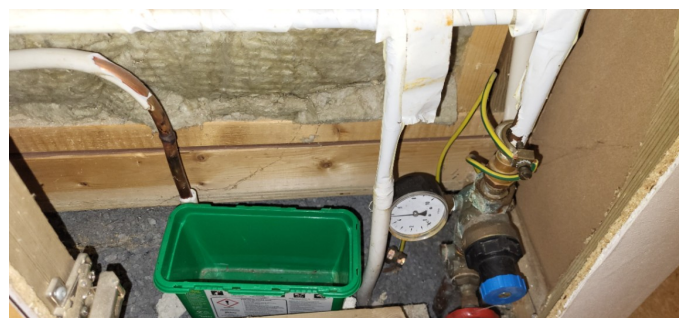
Vannrør og stoppekrane fra byggeår.
