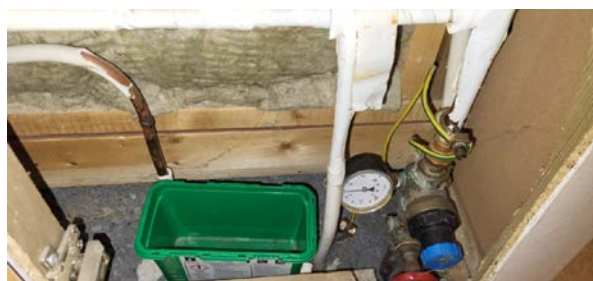
Vannrør og stoppekrane fra byggeår.
