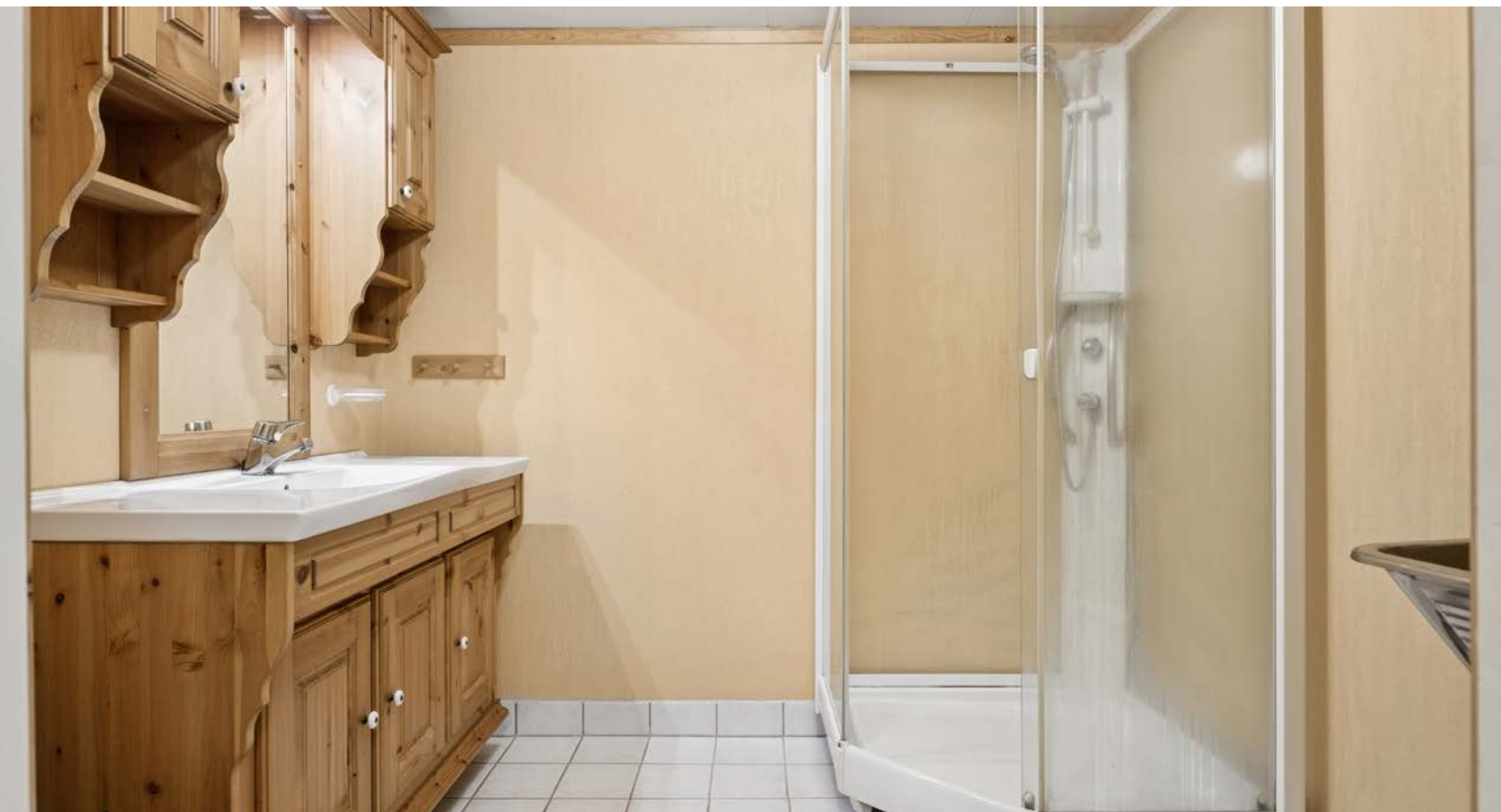
Badet ligger i sokkeletasjen og ble sist renovert i 2000
