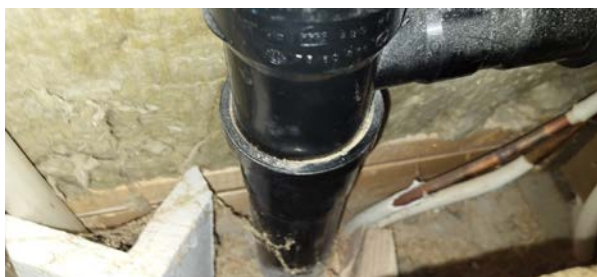
Avløpsrør inspisert via luke i vegg i gang undereasje.
