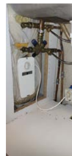
Bereder er plassert i kjøkkenbenk
