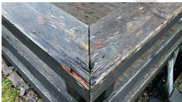
Råteskadet håndløper.
