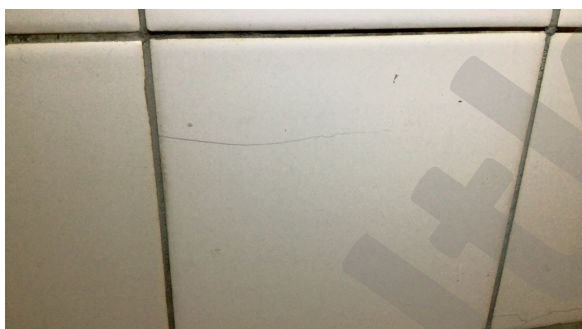
Eksempel på sprukket flis.
