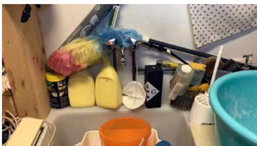
Det er ikke tettesjikt i den definerte våtsonen over vaskeum.
