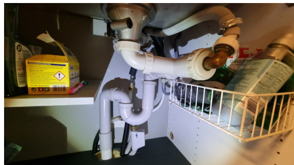
Kontroll av røropplegg under oppvaskkummen.
