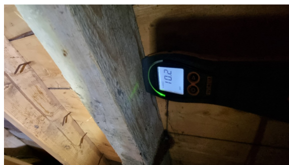
Fuktmåling i takkonstruksjonen, ingen unormale fuktverdier ble registrert
