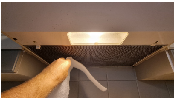
Funksjonstesting av avtrekk over komfyr.
