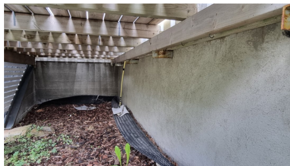
Kontroll av fundamenteringen under terrassen.
