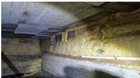
Inspeksjon av krypkjeller med utvendig adkomst
