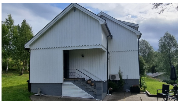
Takoverbygget trapp til hovedinngangen.
