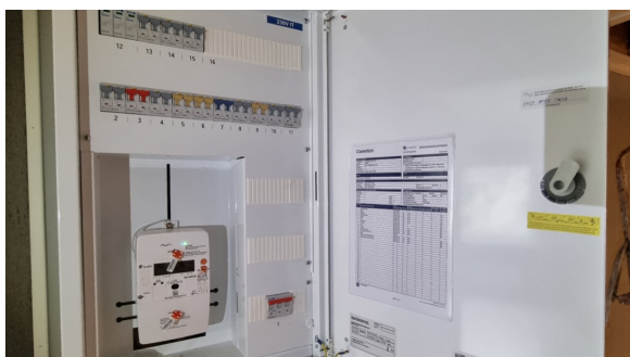
Kontroll av el-skapet.
