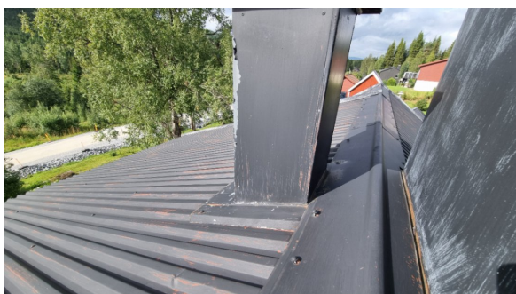
Overflateavflassing i pipebeslag og luftehatt.
