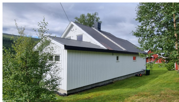
I bakkant av boligen heller terrenget ned mot boligen, dog relativt flatt de nærmeste 2-3 meterne inn mot vegg.
