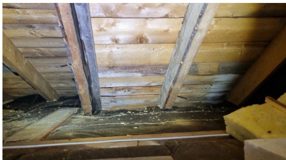
Inspeksjon av kaldloftet.
