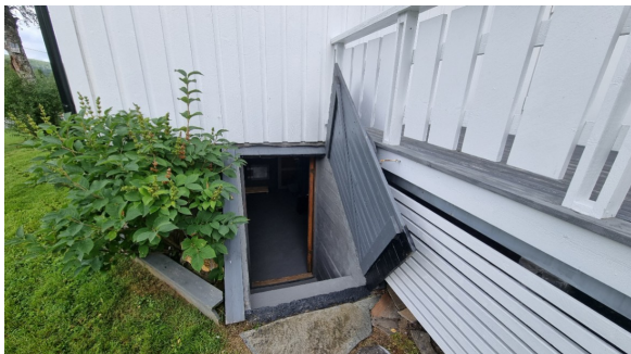
Kjellerlem over kjellerdøren.
