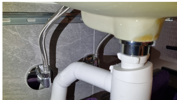
Kontroll av røropplegg under servanten.
