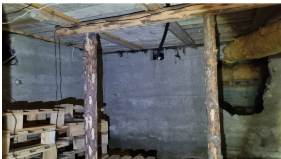
Understøtter av tre i krypkjeller med utvendig adkomst.
