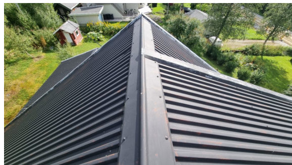
Visuell besiktelse av taket
