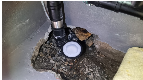
Kjellergulvet er hugget opp ved sluk.
