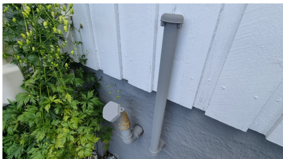
Utvendige påfyllingsrør til oljetanken.
