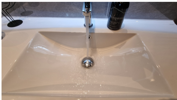
Kontroll av vanntrykk og avrenning.
