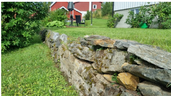
Forstøtningsmur av naturstein.
