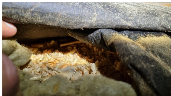
Kontroll av isolasjonen i loftskillet.
