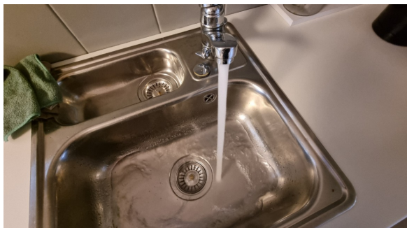
Kontroll av vanntrykk og avrenning.
