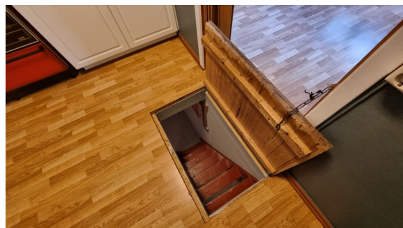
Enkel tretrapp under luke i kjøkkengulvet.
