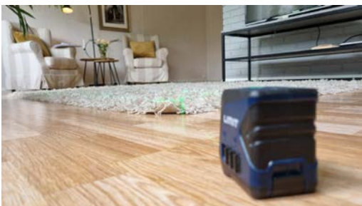
Kontroll av planavvik og skjevheter med krysslaser.
