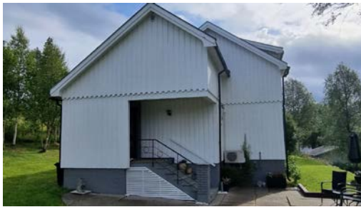
Takoverbygget trapp til hovedinngangen.
