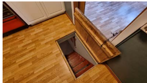
Enkel tretrapp under luke i kjøkkengulvet.
