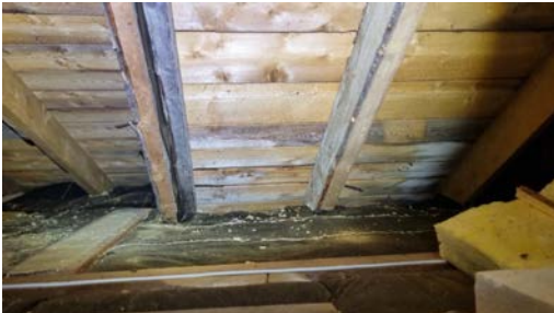
Inspeksjon av kaldloftet.
