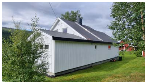
I bakkant av boligen heller terrenget ned mot boligen, dog relativt flatt de nærmeste 2-3 meterne inn mot veggen.
