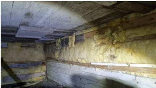
Inspeksjon av krypkjeller med utvendig adkomst
