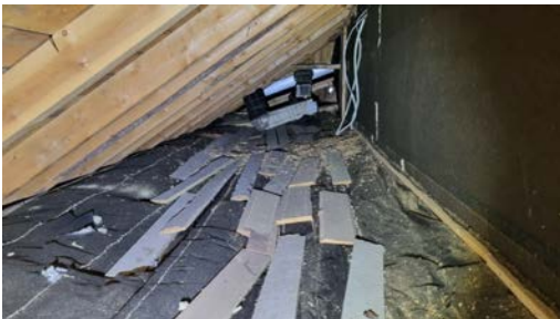
Inspeksjon av knekott.
