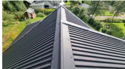
Visuell besiktelse av taket
