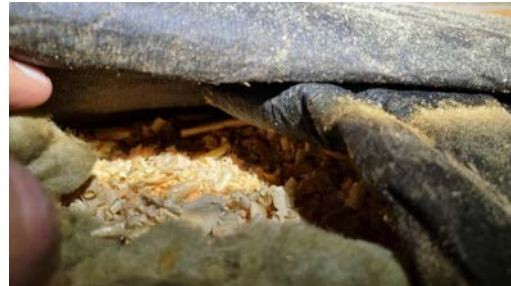
Kontroll av isolasjonen i loftskillet.
