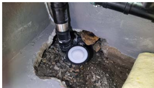
Kjellergulvet er hugget opp ved sluk.
