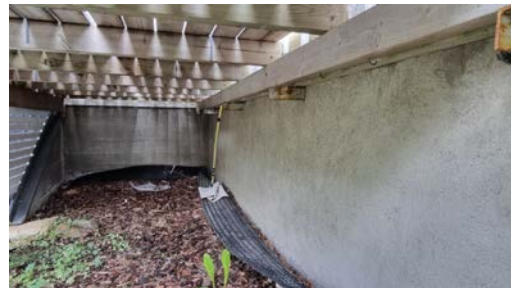
Kontroll av fundamenteringen under terrassen.
