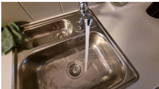
Kontroll av vanntrykk og avrenning.
