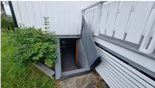
Kjellerlem over kjellerdøren.
