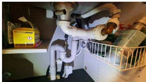
Kontroll av røropplegg under oppvaskkummen.
