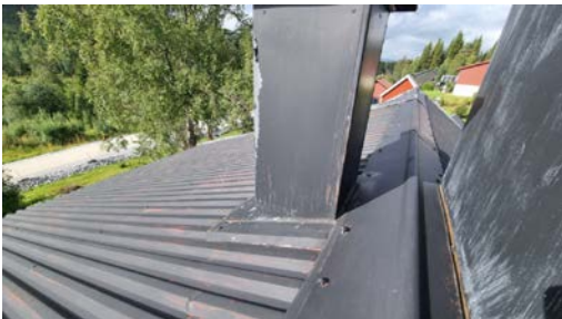
Overflateavflassing i pipebeslag og luftehatt.
