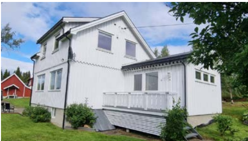
Terrassen er oppført utenfor fasade sør
