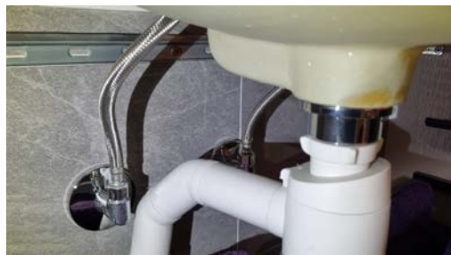
Kontroll av røropplegg under servanten.
