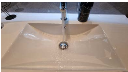
Kontroll av vanntrykk og avrenning.
