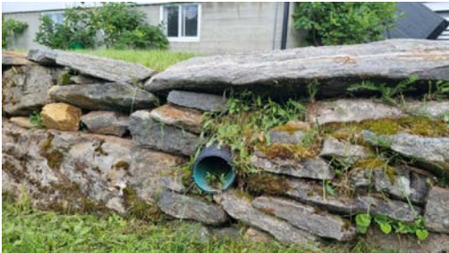
Takvannet blir ledet bort.
