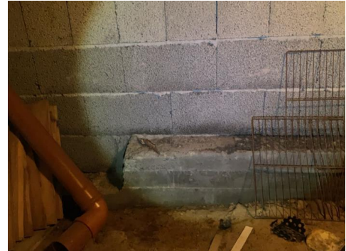
Grunnmur med støpte stripefundamenter.
