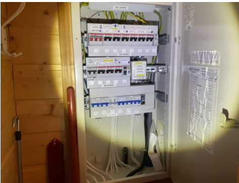
Sikringskap i 1. etasje med automatsikringer.
