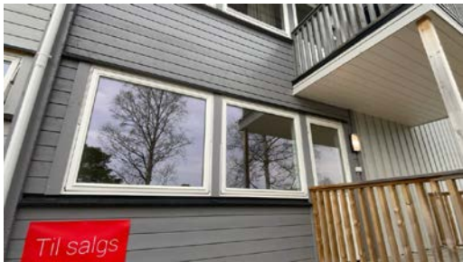
Vinduer på stue
