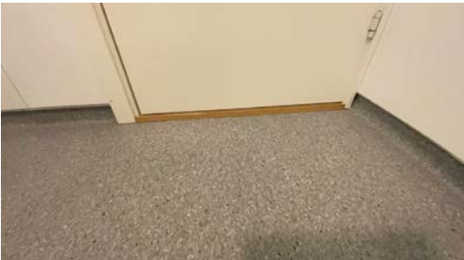
Det er skiftet dørterskel og fuget ved dør etter befaring
