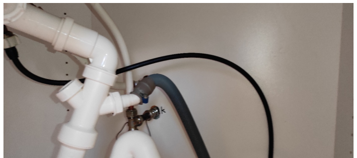
Kontroll av røropplegg.
