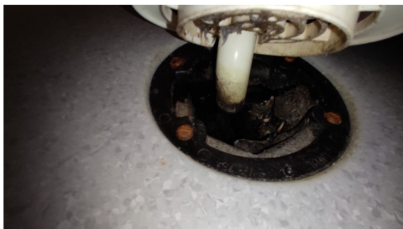
Kontroll av sluk.
