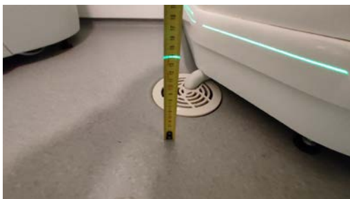
Kontroll av fallforhold.
