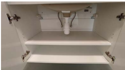
Kontroll av røropplegg.
