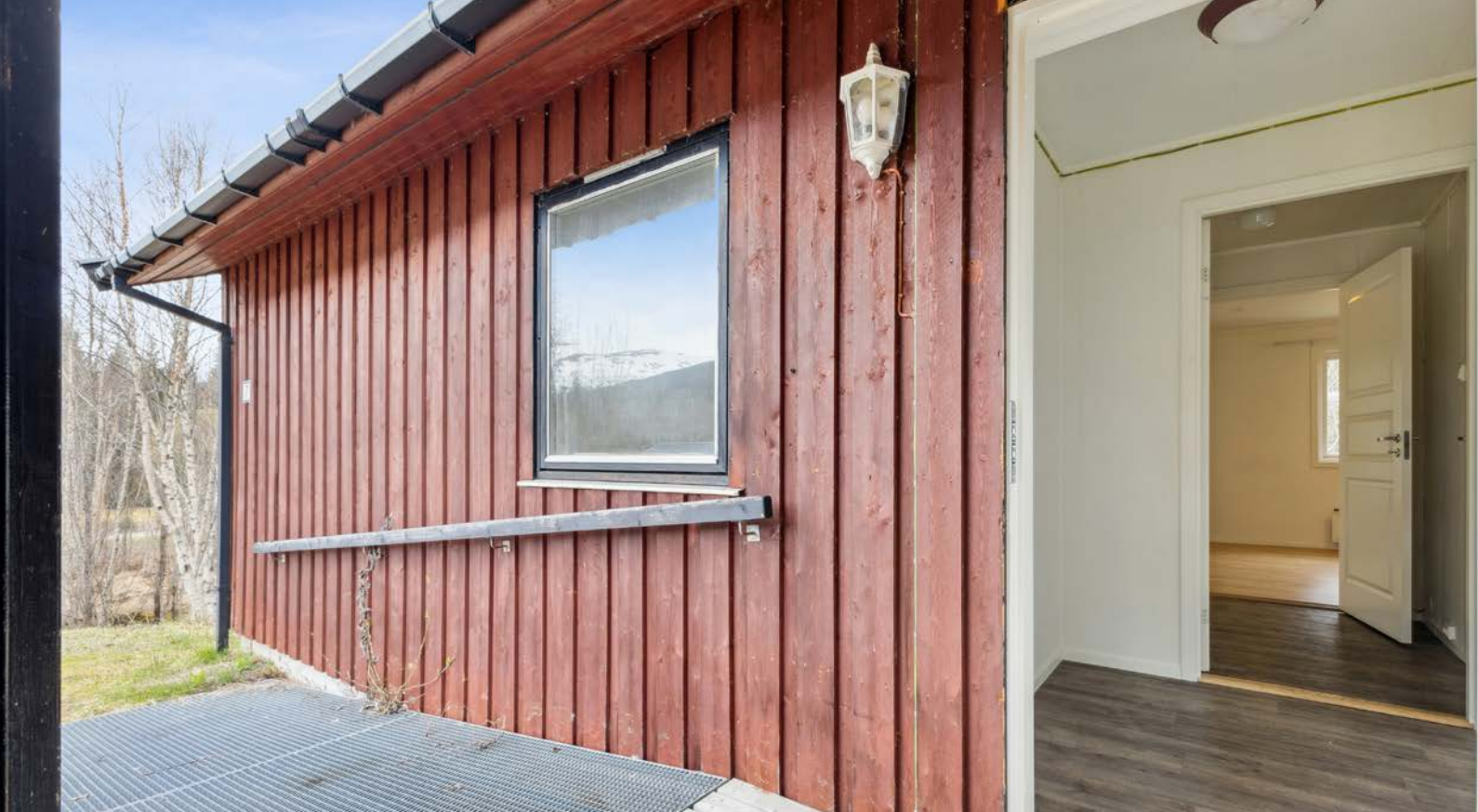
Inngangsparti til Elvevegen 5B
