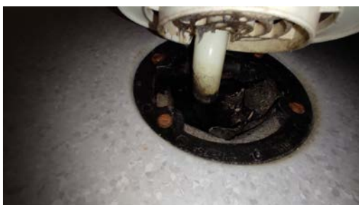
Kontroll av sluk.
