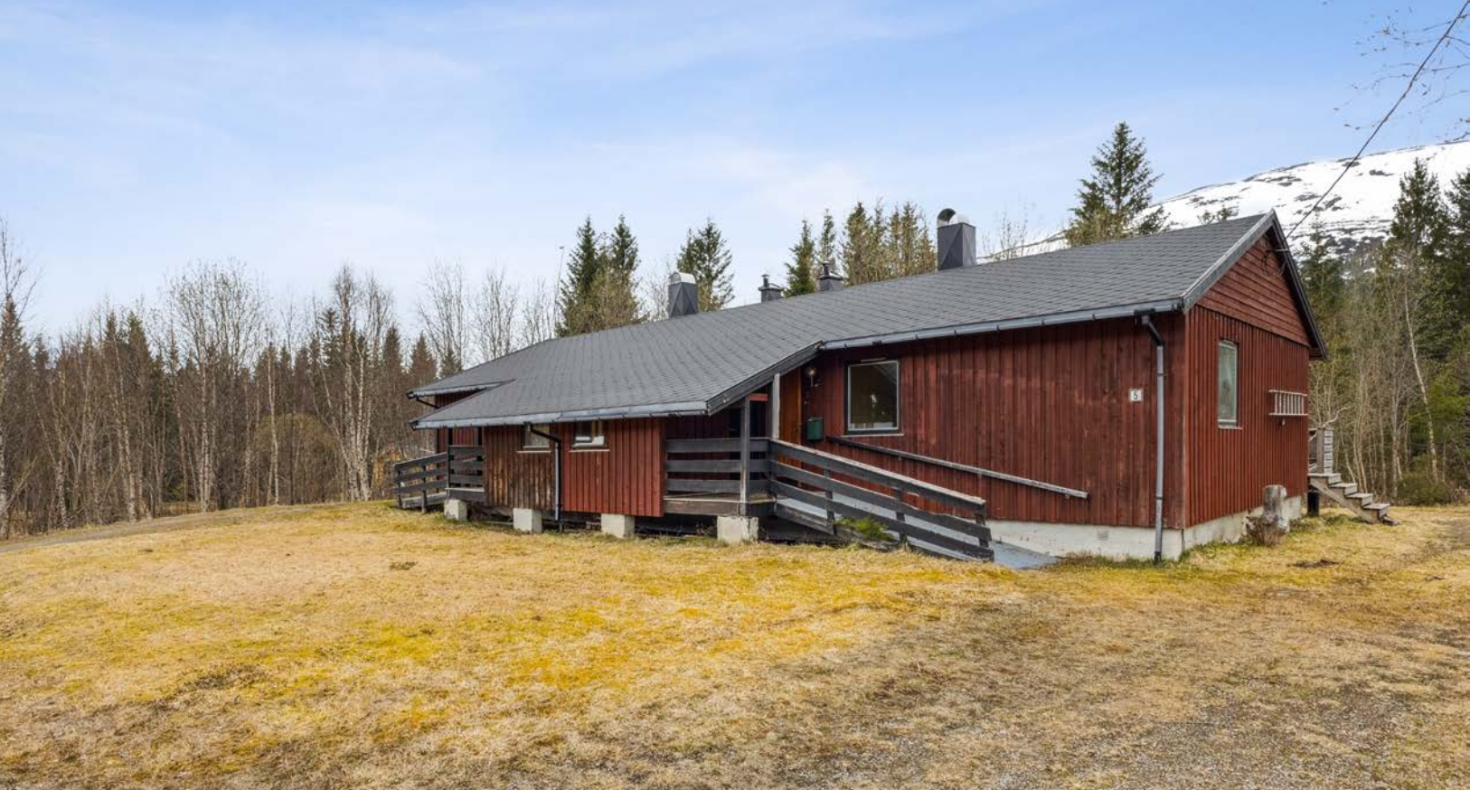
Fasade og inngang til Elvevegen 5A
