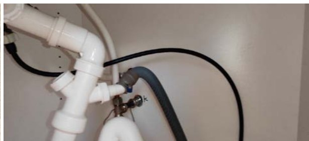
Kontroll av røropplegg.
