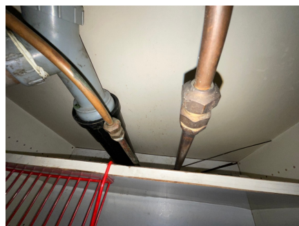
Kobber rør i kjøkkenben
