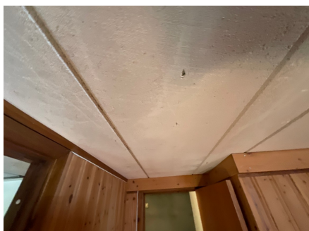
Etasjeskille av lettbetong/ siporex
