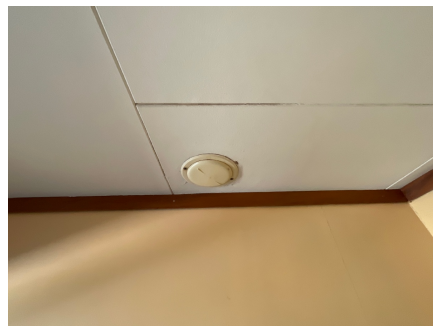
Fuktskader på himling ved ventil
