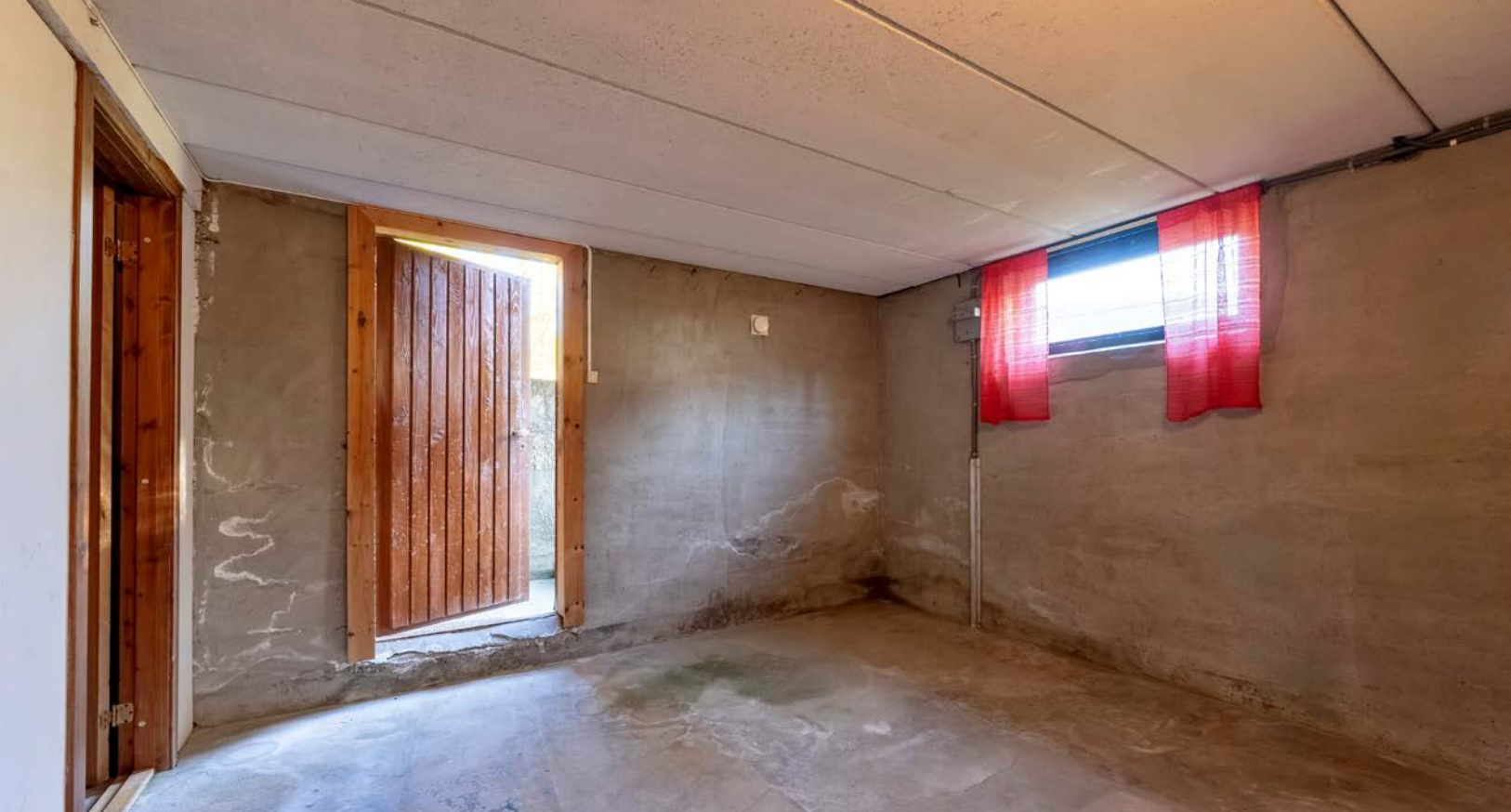
Bod på 11 m 2 med egen inngang via utvendig trapp
