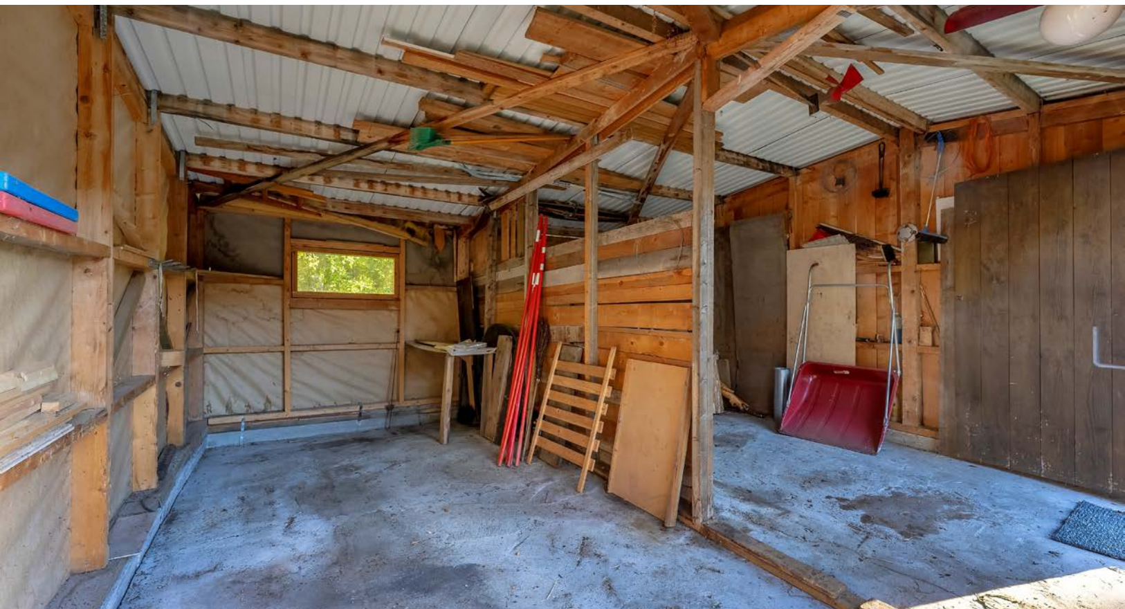
Eldre garasje/uthus på ca. 23 m 2
