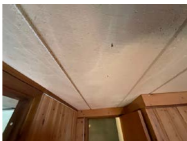
Etasjeskille av lettbetong/ siporex
