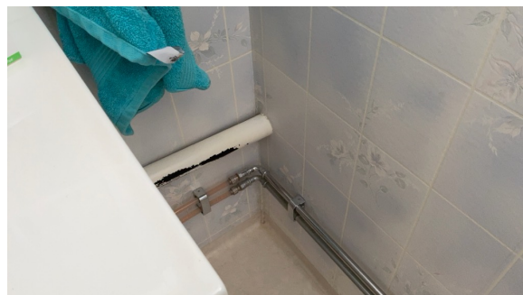
Avløpsrør på bad ledes i yttervegg.
