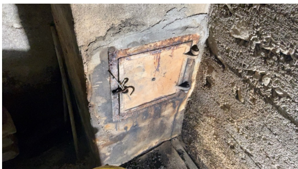
Sotluke i kjeller.
