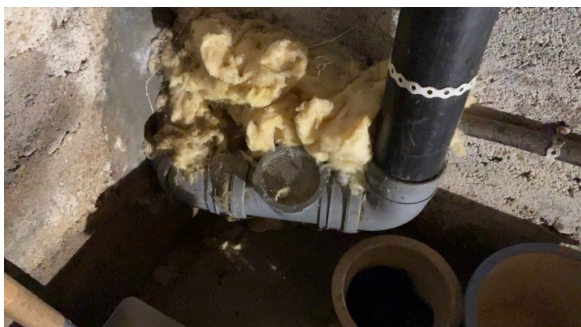
Stakepunkt i kjeller.
