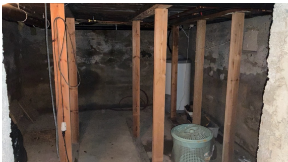
Eksempel på understøttelse av gulvkonstruksjon.
