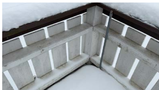
Eksempel på slitasje/misfarging på hovedveranda.
