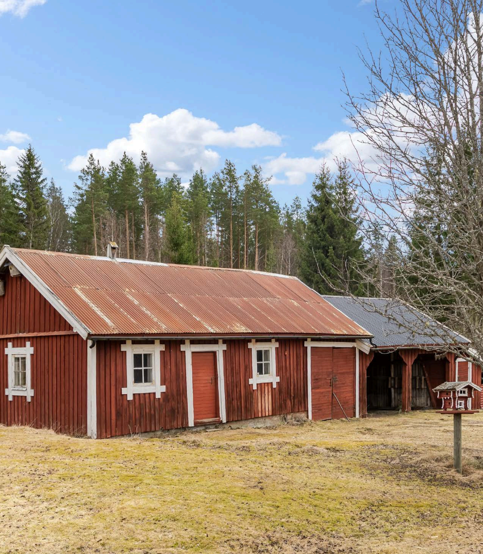
Et eldre uthus/garasje på 67 m 2 som har reisverksvegger og tak tekket med metallplater.
