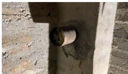
Åpent røykrør i kjeller.
