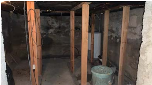
Eksempel på understøttelse av gulvkonstruksjon.
