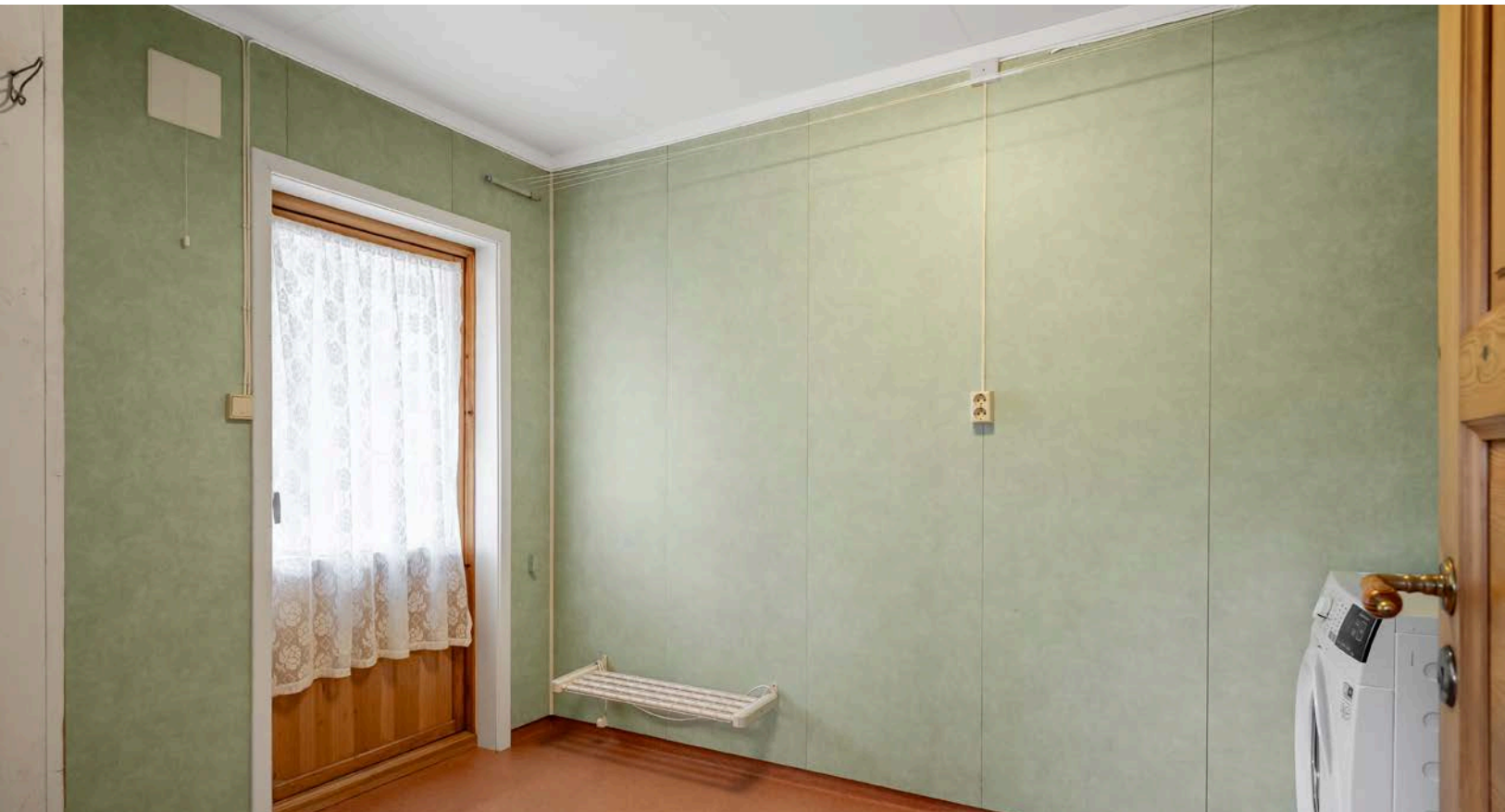
Vaskerommet har baderomsplater på veggene, vinylbelegg med oppbrett på gulv, naturlig ventilasjon og direkte adkomst ut.
