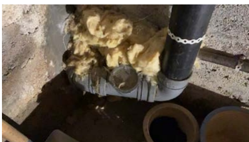
Stakepunkt i kjeller.
