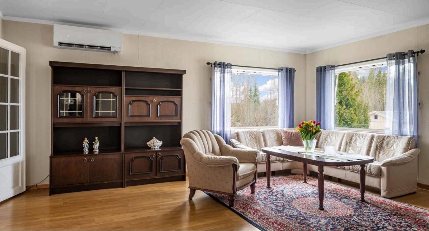
Varmepumpe fra 2015 installert i stuen.
