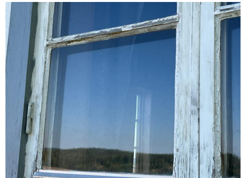
Stor værslitasje, kitt rundt glass er borte
