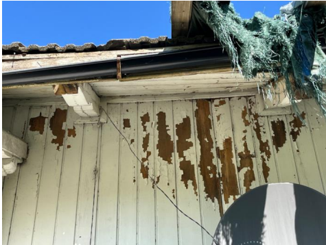
Råteskadet kledning
