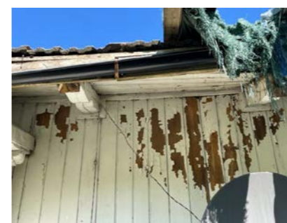
Råteskadet kledning
