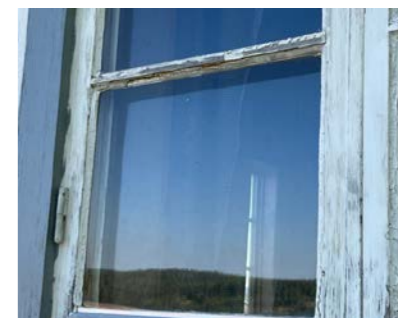
Stor værslitasje, kitt rundt glass er borte
