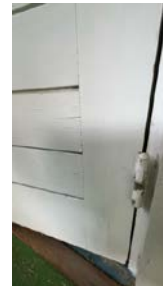
Karmene i dører er værslitte utvendig og det er sprekker i treverket.
