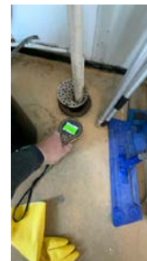
Ved bruk av fuktindikator registrerte jeg ingen unormale verdier.
