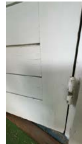
Karmene i dører er værslitte utvendig og det er sprekker i trevirket.
