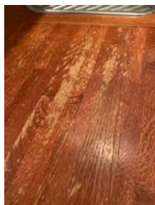
Slitasje på benkeplaten, overflatebehandling
