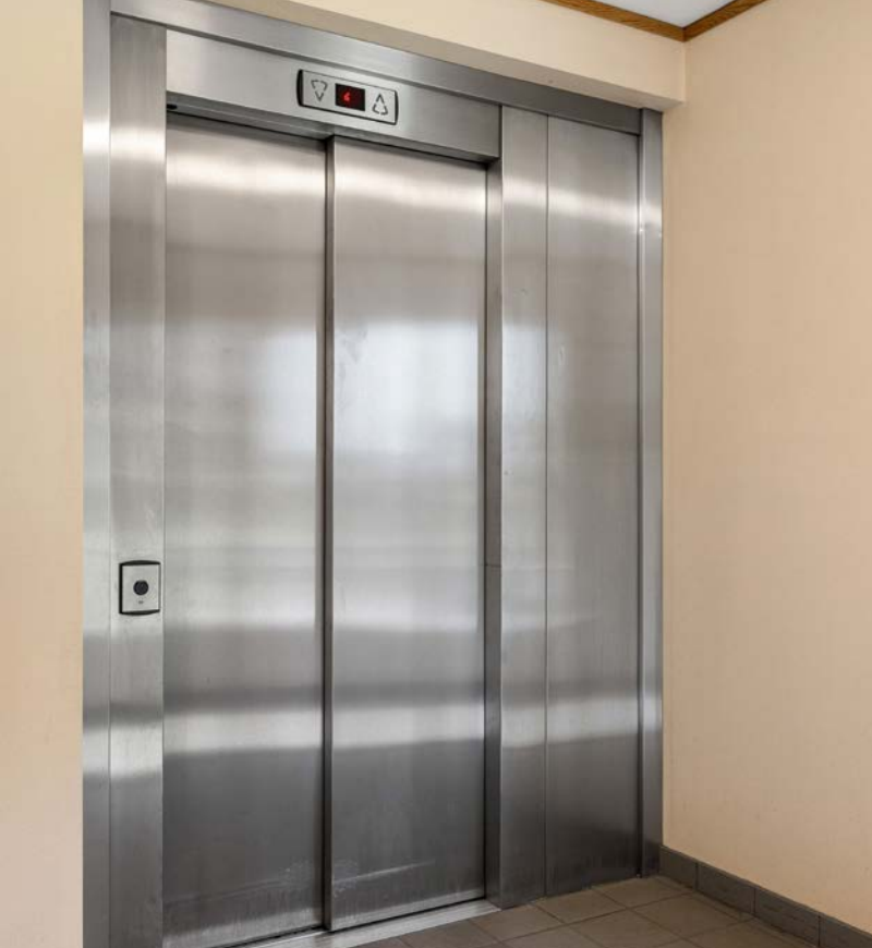
Det er heis i bygget.
