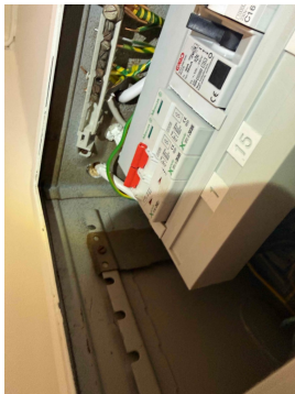
Bildet viser utett gjennomføring i sikringskapet.
