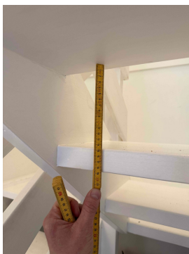
Bildet viser åpning mellom trinnene.
