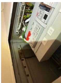
Bildet viser utett gjennomføring i sikringskapet.
