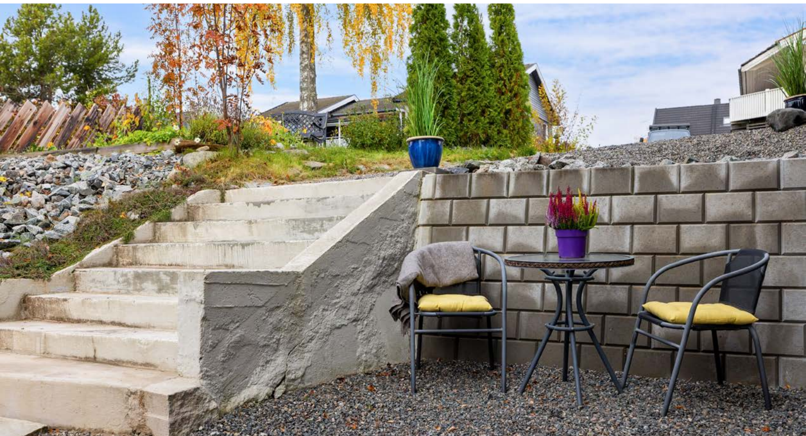
Tomten ble oppgradert i 2021 med bla. støttemur, kantstein mot nabo og trekantet steinbed, betongheller langs vegg bakside, og liten terrasse med duk og betongheller nedenfor veranda.
