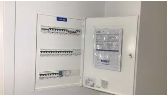
TG 0 Branntekniske forhold
