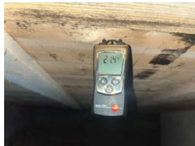
Fuktmåling i kryperom.
