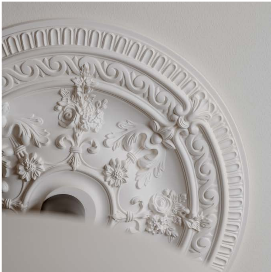
Lampen henger fint fra den vakre rosetten i taket. Fra gammelt av ble rosettene brukt som brannskille, da oljelamper og levende lys var den eneste formen for belysning.
