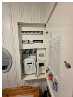
Mangler dekkplate ved sikringer.
