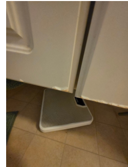
Skade i nedre del av skapdører.
