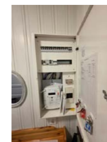
Mangler dekkplate ved sikringer.
