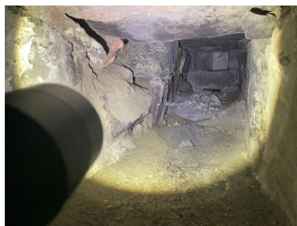
Tykke grunnmurer, kanal gjennom grunnmur fra kjeller under stue.
