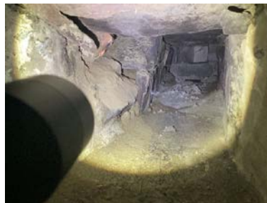
Tykke grunnmurer, kanal gjennom grunnmur fra kjeller under stue.
