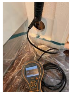
Fuktmåling i vegg mot våtsone.
