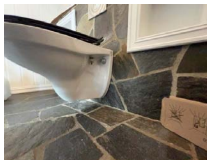
Vegghengt toalett har ikke lekkasje varsler.
