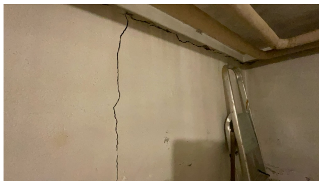
Horisontal og vertikalsprekk
