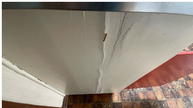
Sprekk/skade sideskrog.
