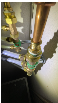
Dråpe på rørkobling kaldtvannsfordeler
