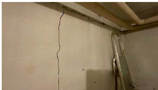
Horisontal og vertikalsprekk
