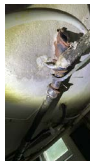
Eldre bunnledning og rør til kjøkken
