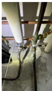
Dråpe på rørkobling kaldtvannsfordeler
