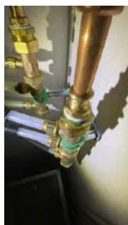
Dråpe på rørkobling kaldtvannsfordeler
