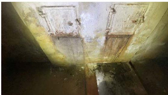
Rennestriper etter sotvann
