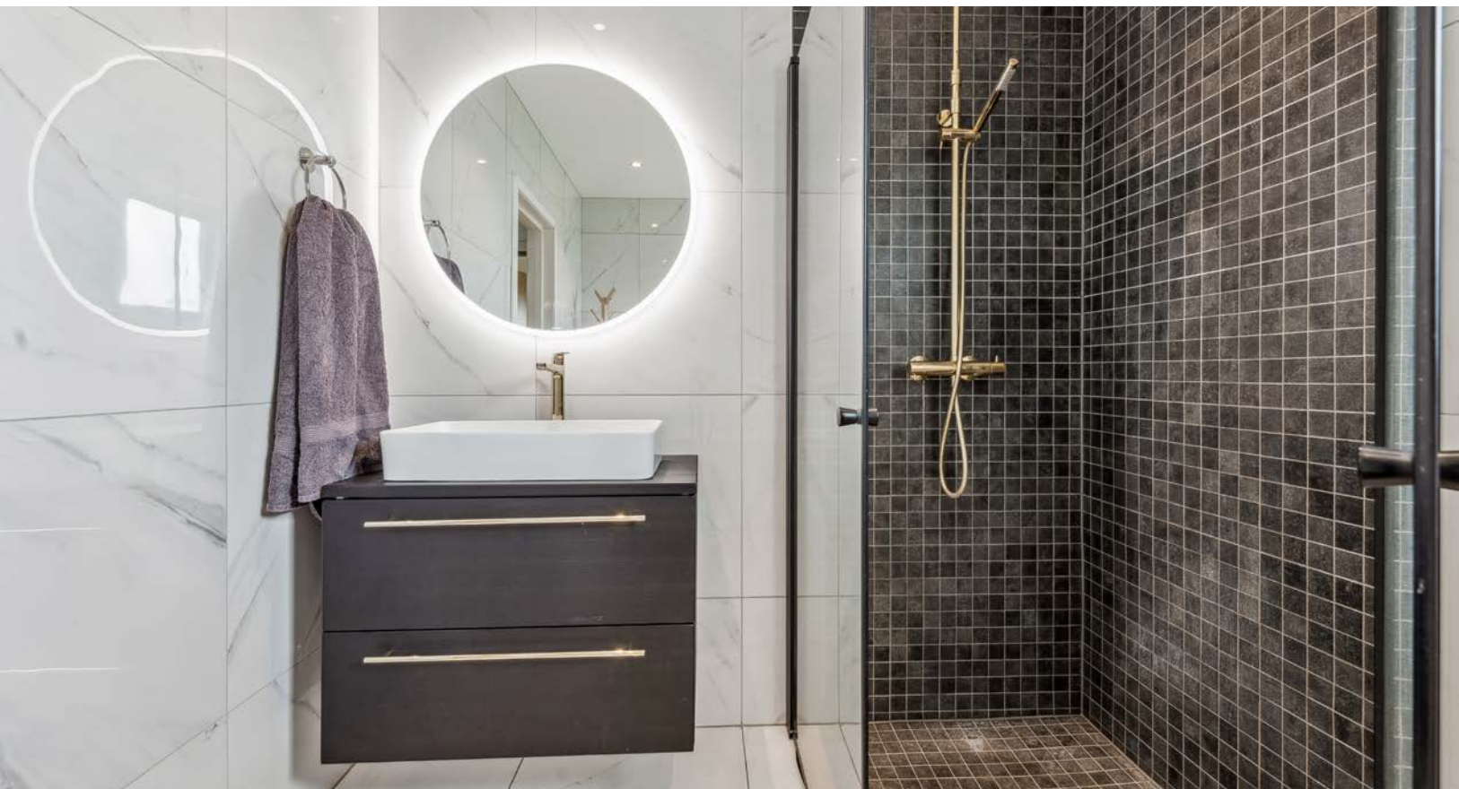
Flislagt med storformatflis og mosaikk i dusjhjørne. Det er varmekabler i gulv.
