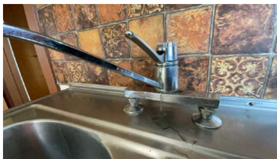
Kjøkkenkran lekker ved tapping
