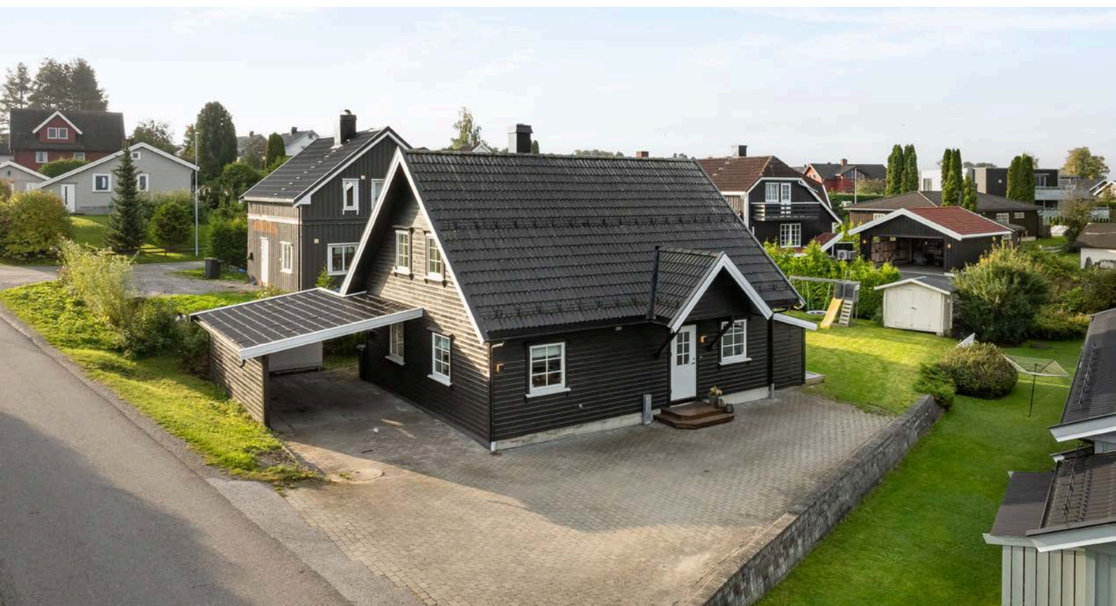
Til høyre for inngangspartiet er det adgang til utvendig bod på ca. 4m 2 .
