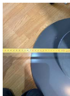
Bildet viser at avstanden mellom vedovn og laminatgulv er mindre enn 30 cm
