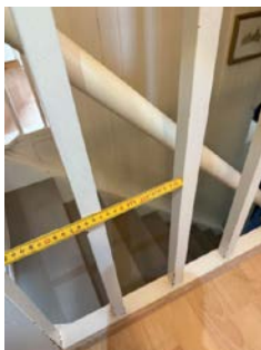
Bilde av åpninger i rekkverk på den ene siden.
