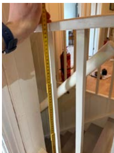
Bilde av åpninger i rekkverk på den ene siden.
