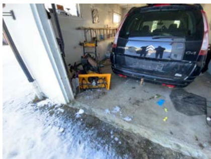
Besiktigelse av garasje. Generell slitasje, elde og behov for vedlikehold.
