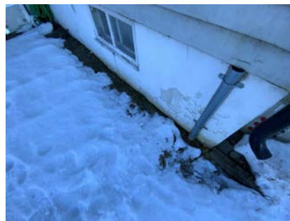
Kontroll av drenering/fuksikring.
