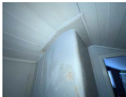
Kontroll rundt pipeløp.
