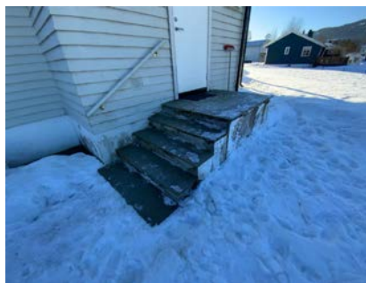
Besiktigelse av trapp.
