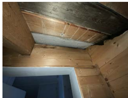
Minimalt med luftespalter på isolert del.
