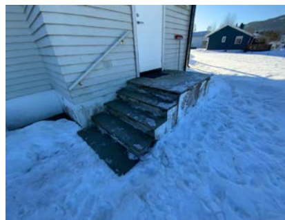
Besiktigelse av trapp.
