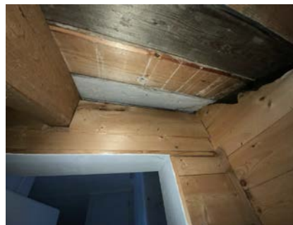
Minimalt med luftespalter på isolert del.
