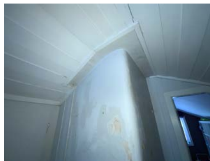
Kontroll rundt pipeløp.
