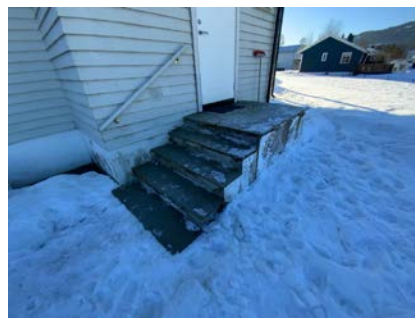
Besiktigelse av trapp.
