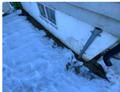
Kontroll av drenering/fuktsikring.
