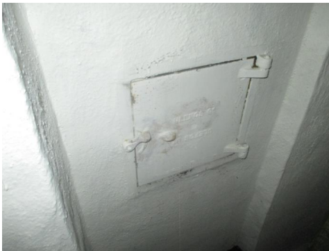
Sotluke i kjeller.
