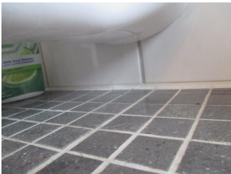
Ingen hull for synliggjøring av lekkasjevann.
