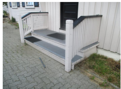
Trapp ved inngangsparti.
