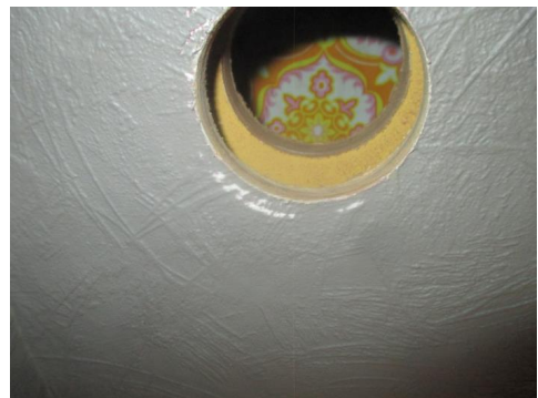
Hulltaking i trappegang til kjeller.
