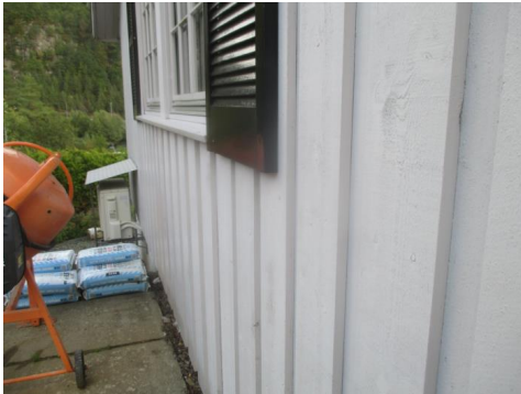
Deler av ene fasaden.
