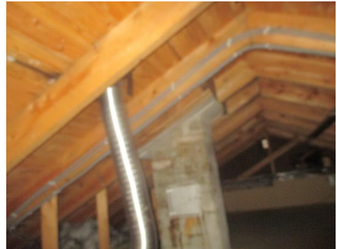
Deler av takkonstruksjonen.
