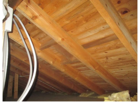
Deler av undertaket av rupanel
