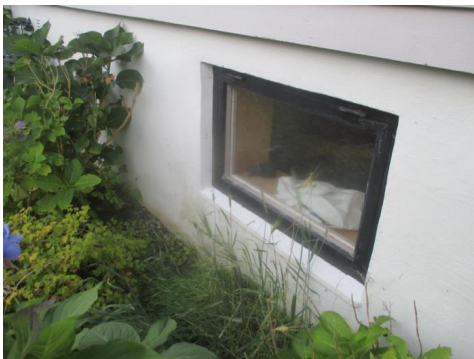
Eldre opprinnelige kjellervinduer.
