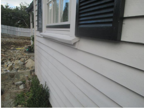
Deler av kledningen med tilhørende belistninger.
