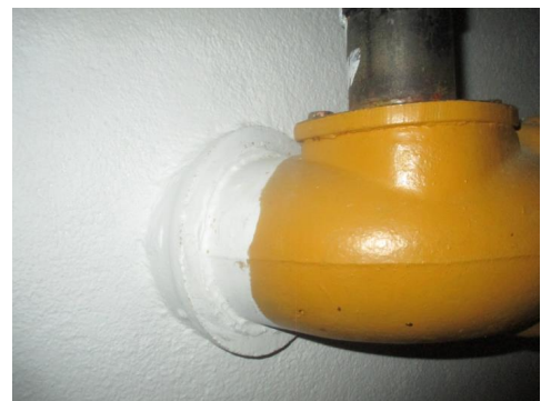
Opprinnlige avløpsrør ut av boligen.
