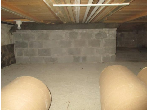
Deler av krypkjeller med støpt dekke.
