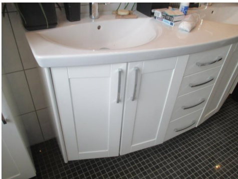
Ingen hull for synliggjøring av lekkasjevann.
