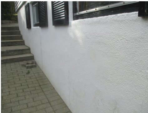
Deler av grunnmur.
