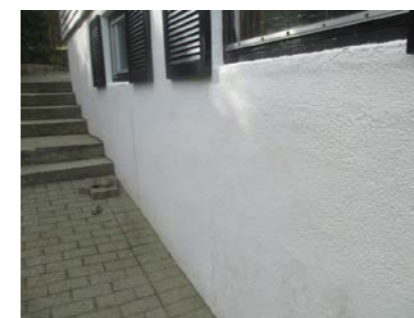
Deler av grunnmur.
