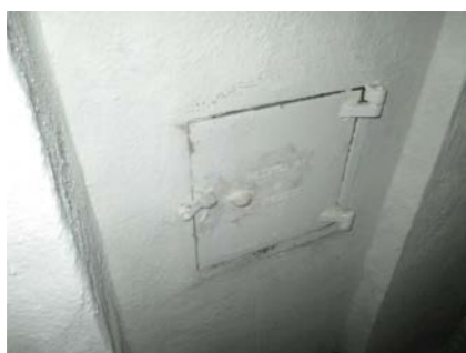
Sotluke i kjeller.
