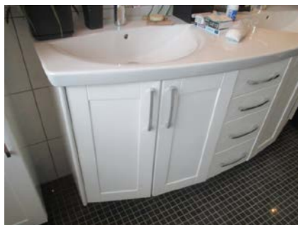
Ingen hull for synliggjøring av lekkasjevann.
