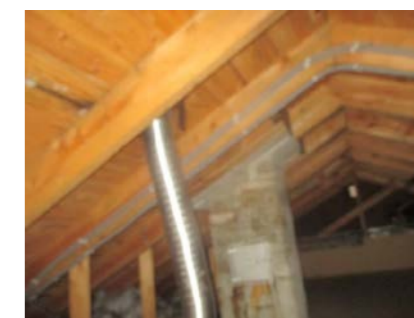
Deler av takkonstruksjonen.
