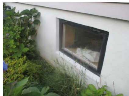
Eldre opprinnelige kjellervinduer.
