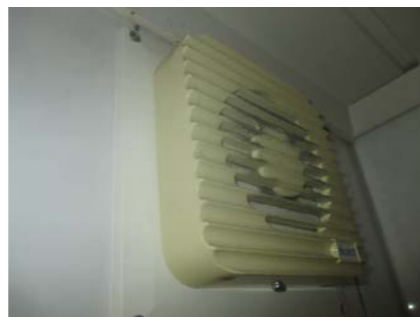
Noe eldre vifte i ytterveggen.
