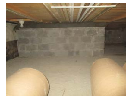
Deler av krypkjeller med støpt dekke.
