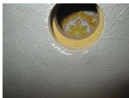
Hulltaking i trappegang til kjeller.
