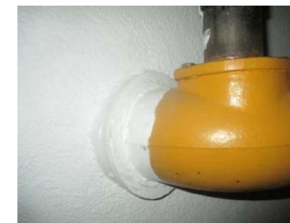
Opprinnelige avløpsrør ut av boligen.
