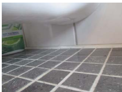
Ingen hull for synliggjøring av lekkasjevann.
