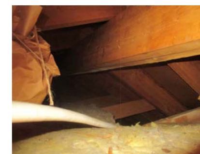
Konstruksjonen over stue.
