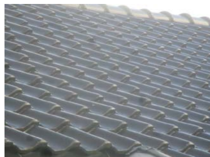
Deler av taktekkingen.
