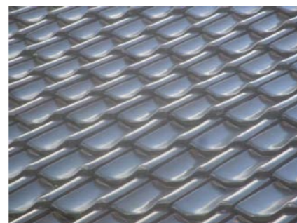
Taktekkingen har kun normal slitasje.
